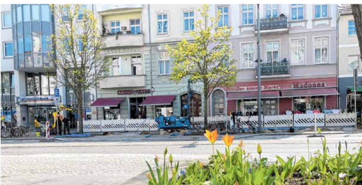
In der Bernauer Straße werden die Gehwege nach Kampfmitteln abgesucht.
